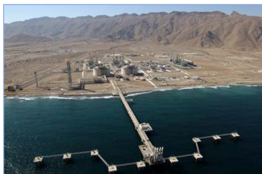
Qalhat LNG facility of Oman LNG
