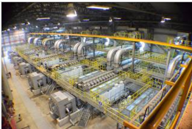
Sieben MAN 32/44CR Motoren stellen rund 78MW an elektrischer Energie zur Verfügung
