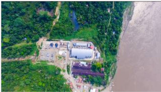
Luftaufnahme des Kraftwerks Iquitos
